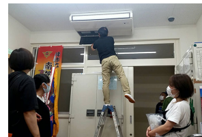
除菌フィルターの取付
